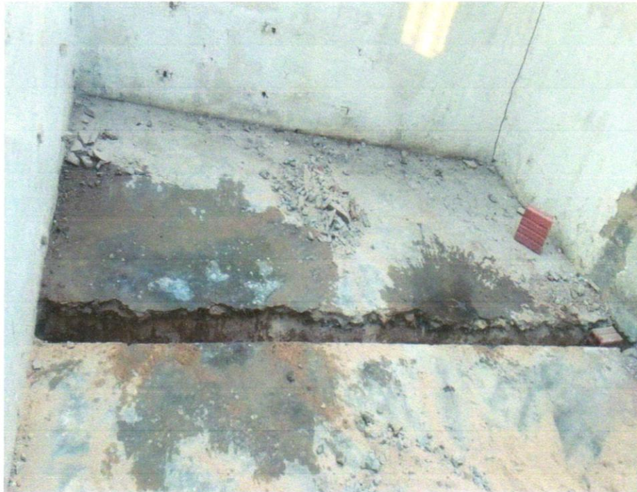
FOTO 07 - ESCAVAÇÃO MANUAL DE VALA PARA VIGA BALDRAME (INCLUINDO ESCAVAÇÃO PARA COLOCAÇÃO DE FÔRMAS). AF_06/2017
