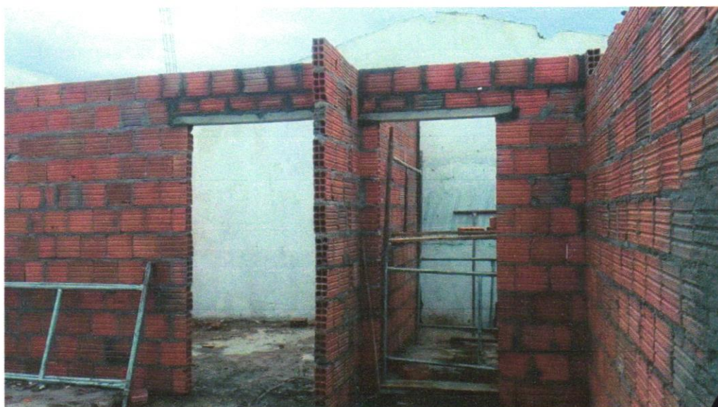
FOTO 02 - ALVENARIA DE VEDAÇÃO DE BLOCOS CERÂMICOS FURADOS NA VISTA HORIZONTAL DE 9X19X29 CM (ESPESSURA 9 CM) E ARGAMASSA DE ASSENTAMENTO COM PREPARO EM BETONEIRA. AF_12/2021
