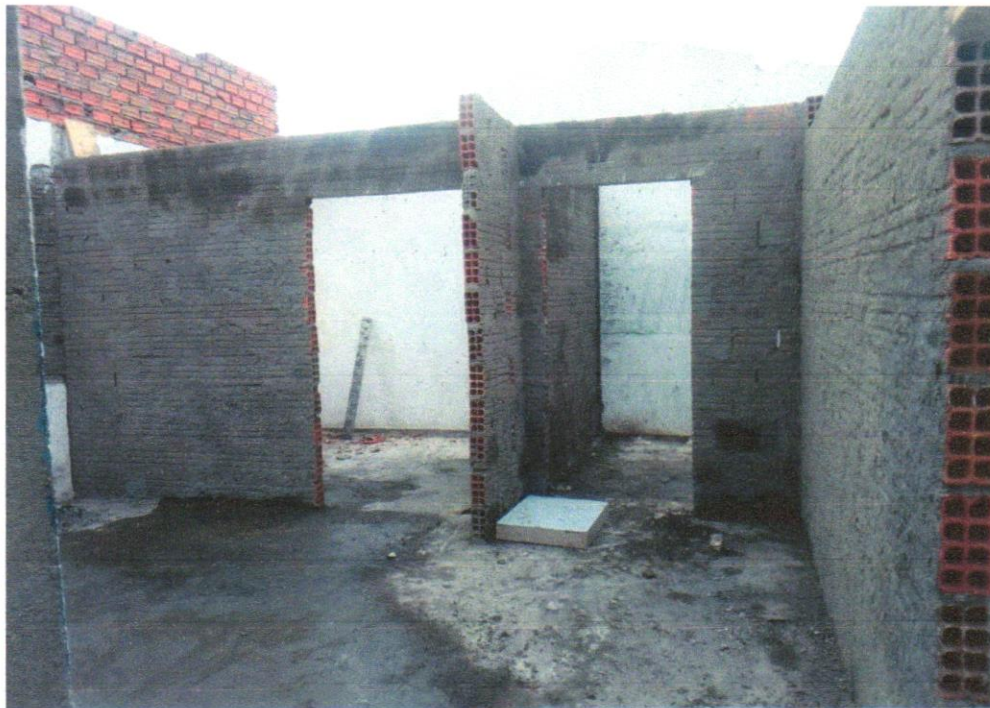
Foto 19 - CHAPISCO APLICADO EM ALVENARIA (COM PRESENÇA DE VÃOS) E ESTRUTURAS DE CONCRETO DE FACHADA, COM EQUIPAMENTO DE PROJEÇÃO. ARGAMASSA TRAÇO 1:3 COM PREPARO EM BETONEIRA 400 L. AF_06/2014
