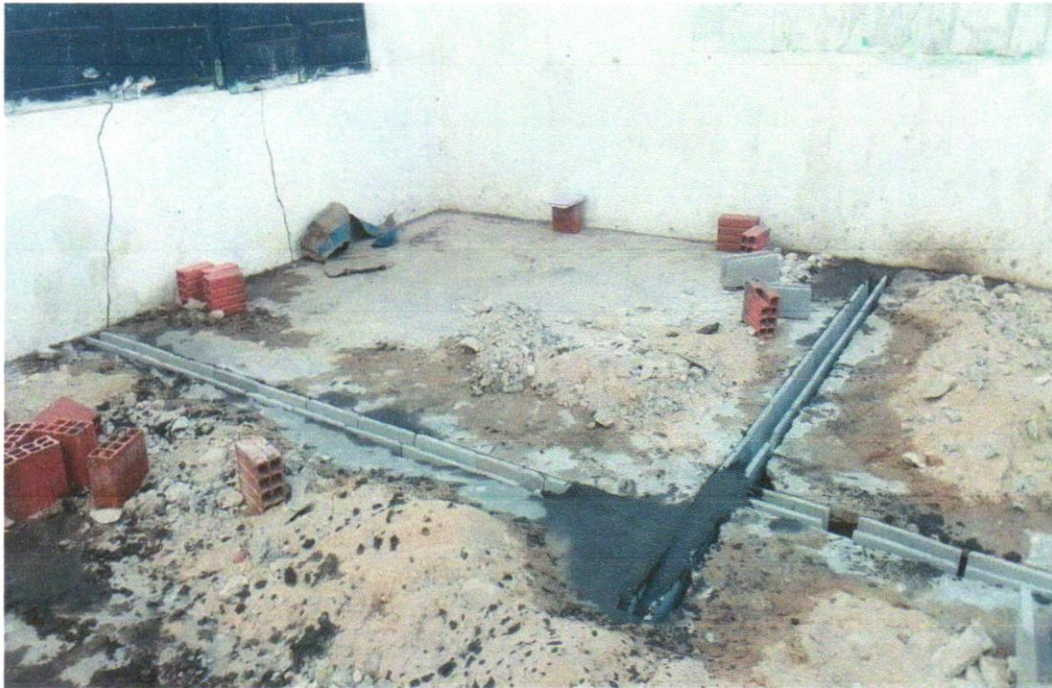
FOTO 09 - Bloco cerâmico tipo "u" (calha) 9x19x19cm
