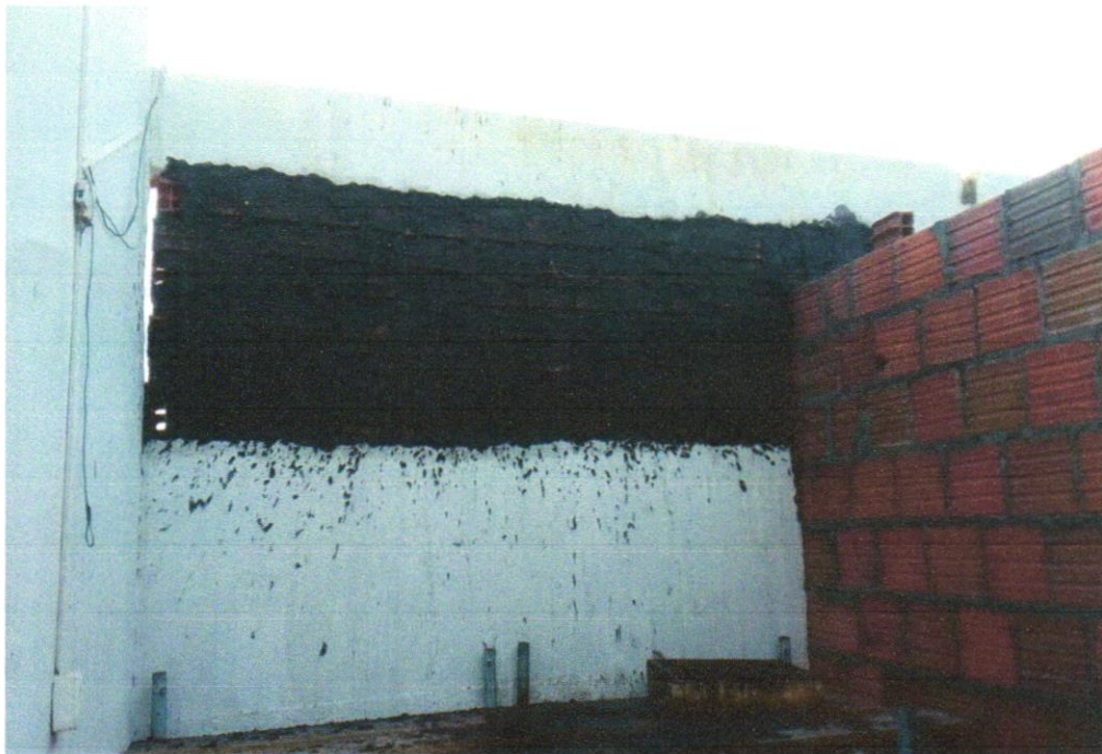
Foto 17 - CHAPISCO APLICADO EM ALVENARIA (COM PRESENÇA DE VÃOS) E ESTRUTURAS DE CONCRETO DE FACHADA, COM EQUIPAMENTO DE PROJEÇÃO. ARGAMASSA TRAÇO 1:3 COM PREPARO EM BETONEIRA 400 L. AF_06/2014
