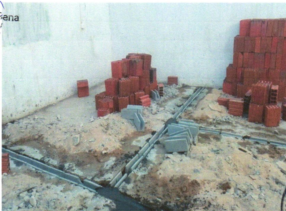
FOTO 08- Bloco cerâmico tipo "u" (calha) 9x19x19cm
