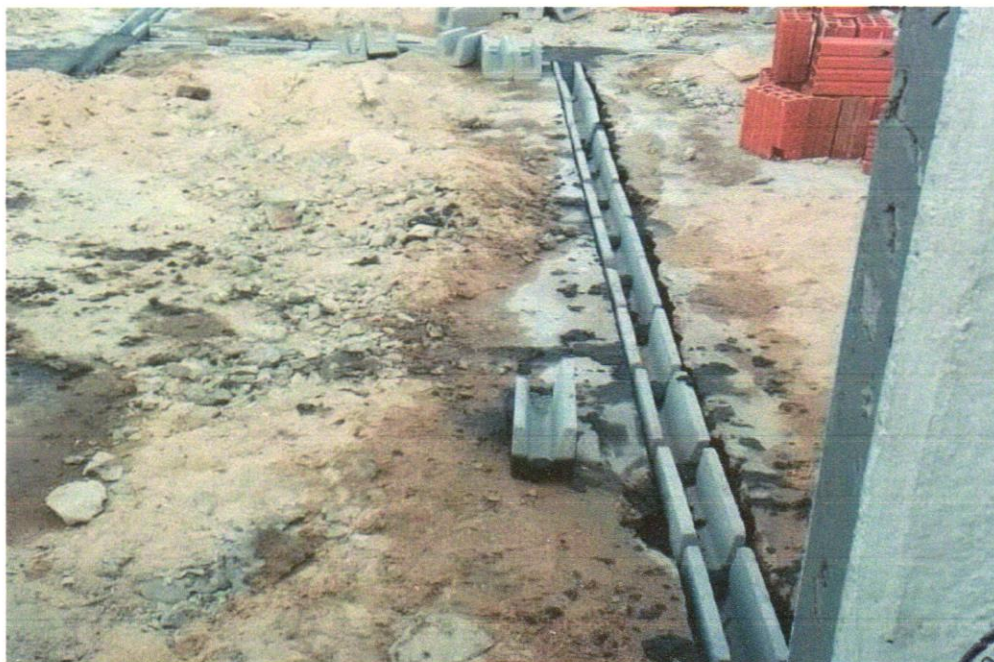
FOTO 10 - Bloco cerâmico tipo "u" (calha) 9x19x19cm
