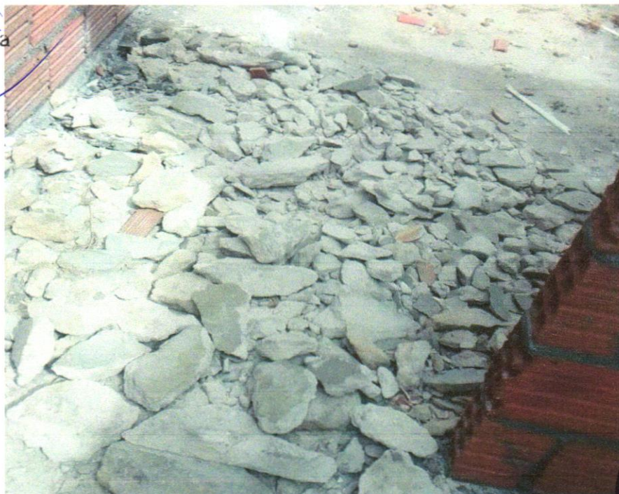
FOTO 06 - Demolição manual de piso cimentado sobre lastro de concreto - Rev 01
